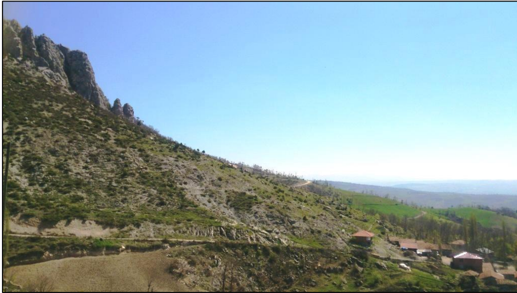
Şekil 6. Arazide tespit edilen kaya düşmesi kaynak alanı (Kabalı Mahallesi, 41.216860°K, 35.569098°D)
