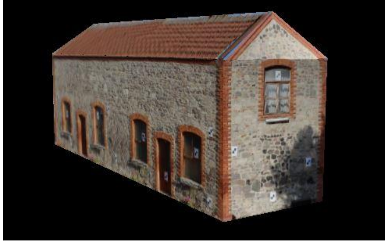
Şekil 4. Yüzey kaplama işlemi
