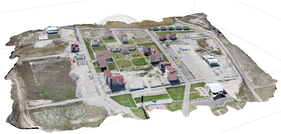
Şekil 2: Çalışma alanına ait nokta bulutu ve yer kontrol noktalarının konumları.
