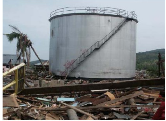
Şekil 6. Solda tsunami dalgalarıyla yer değiştiren güç üreten araç, sağda ise yer değiştiren yakıt tankı. Bu ağır nesnelere yolları üzerindeki evlere hasar verdi. (Saatçioğlu vd., 2005)
