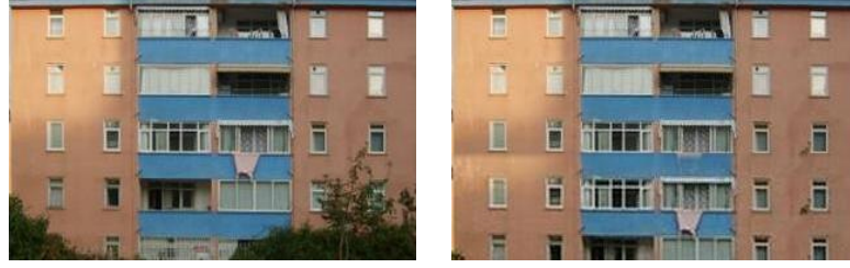
Şekil 7. Engel giderme işleminden önceki (sol) ve sonraki (sağ) bina cephe dokuları
