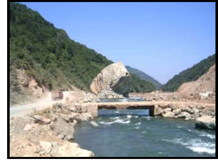
Foto 7. Ardeşen – Çamlıhemşin karayolunun 10.km'sinde oluşan kaya düşmesi.
