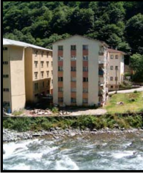
Foto 8. Çamlıhemşin'de akarsu yatağı içerisinde sel riski taşıyan konutlar.
